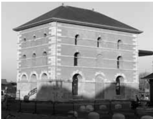
Afb. 6. Het Stoommachinegebouw, het oudste op de Rijkswerf Willemsoord is nu geheel gerestaureerd.
